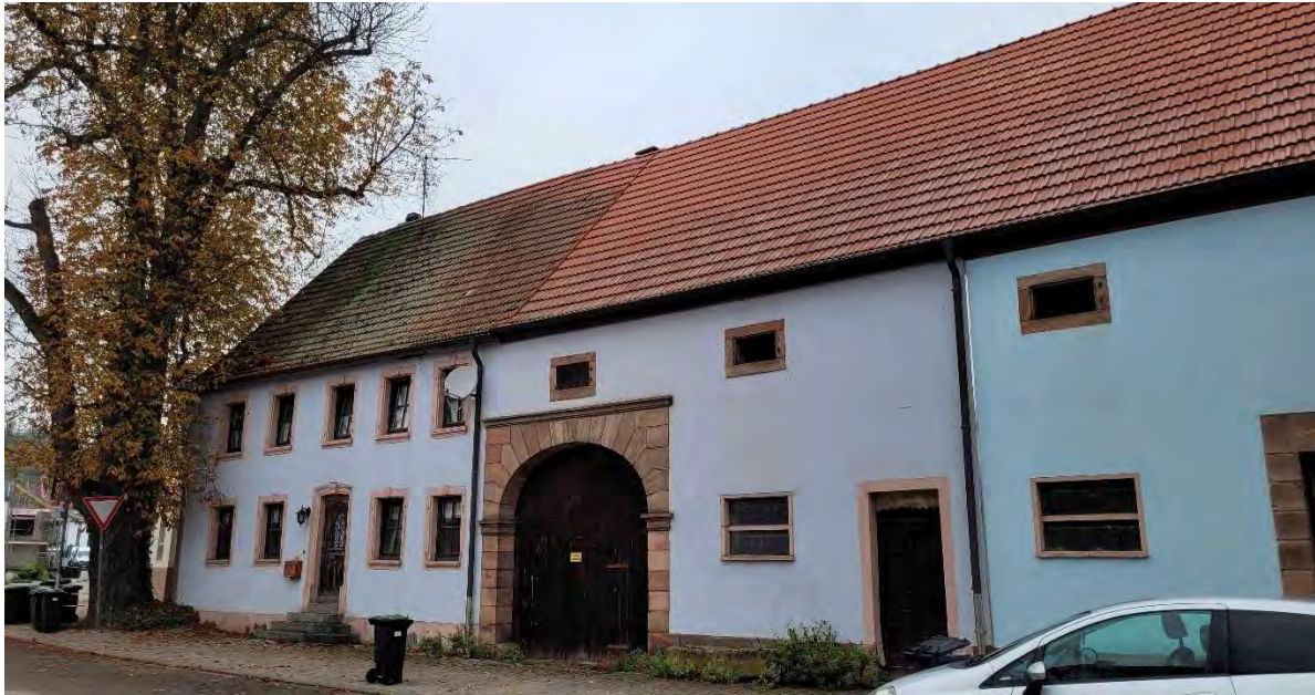
Abbildung 28: Quererschlossenes Einhaus in der Hauptstraße (Quelle: Eigene Aufnahme)
